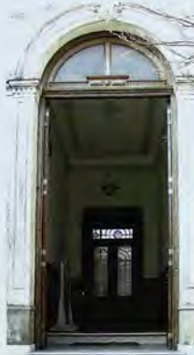
Entrada a la Casa Ronco, donde funciona la Hemeroteca de la entidad.
